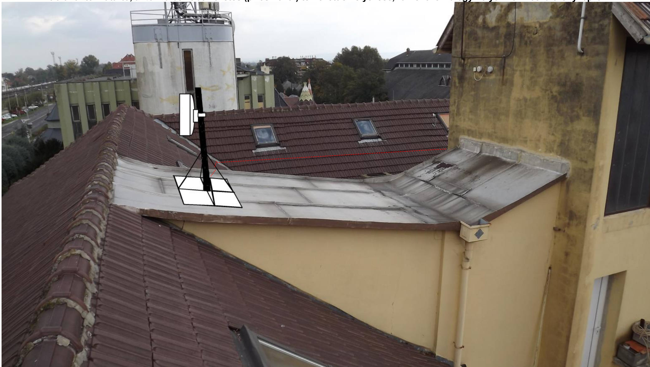
2. ábra: antennatartó, antenna és kábelvezetés (piros vonal) tervezett elhelyezése, rámontírozva egy helyszínen készült fényképre
