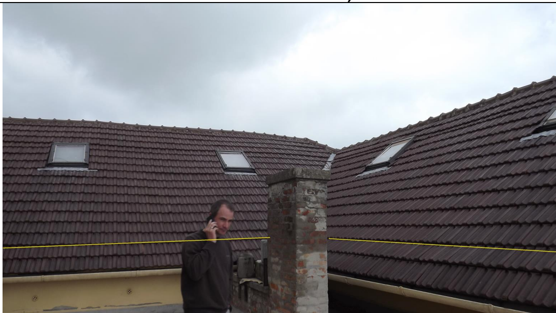
4-6. ábra: kábelvezetés nyomvonala (sárga színnel jelölve a kábelt, mely bújtatva a cserép alatt kerül vezetésre)
