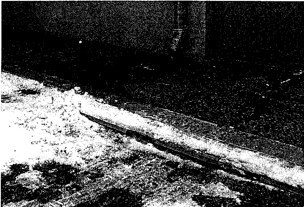
16. ábra: Ereszcsonna kivezetés a Baross u. járdájára (szelvényezéssel ellentétes irányban fényképezve)
