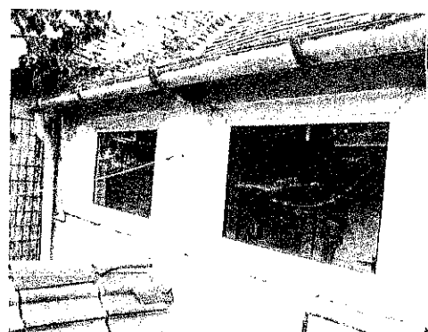
az épület lefedése, hőszigetelés nélküli vb. koszorúja, a csapadékvíz elvezető acéllemez függő-, és lefolyócsatornája
