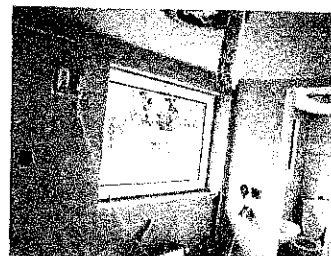
a műanyag kétrétegű hőszigetelt üvegezett ablakok
