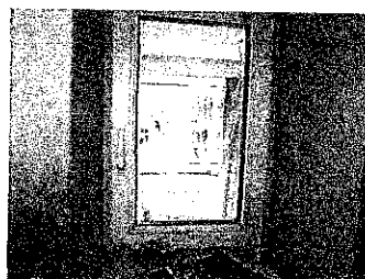
a műanyag kétrétegű hőszigetelt üvegezett ablakok
