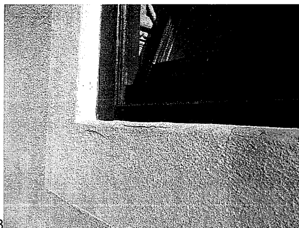
Az utcafront nyílászáróinak könyöklőinél a vakolat repedezett, tönkrement.
