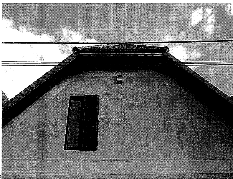
Az utcafront szaruelemeinek festett felületei kopottak, UV és időjárási behatások miatt repedezett, felújításuk szükséges.
