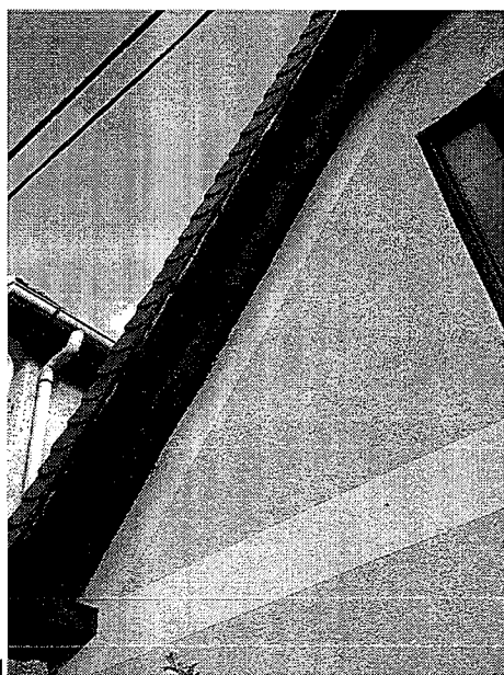
Az utcafront szaruelemeinek festett felületei kopottak, UV és időjárási behatások miatt repedezett, felújításuk szükséges.
