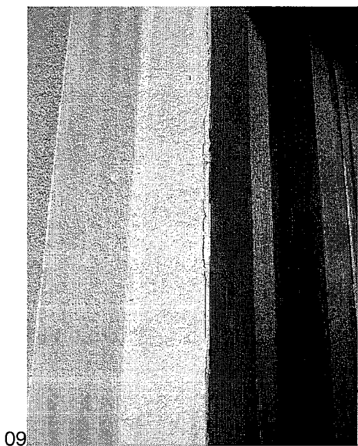
Az utcafront egyéb vakolathelyeinél, jellemzően dilatációs pontokon illetve élek mentén a vakolat repedezett, tönkrement.
