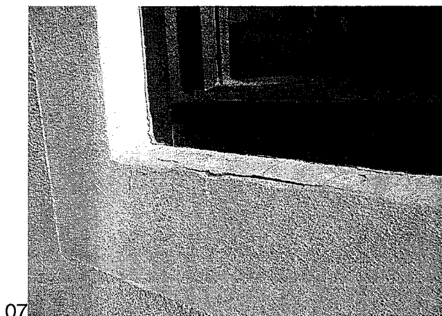
Az utcafront nyílászáróinak könyöklőinél a vakolat repedezett, tönkrement.
