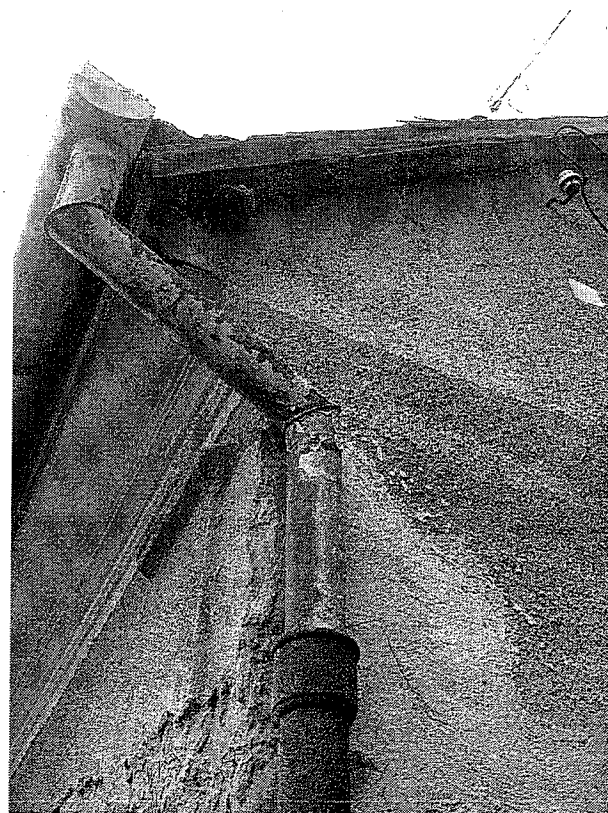
kis ház utcai homlokzati tetőfelületéről ereszcsonal állványcsőbe torkollik
