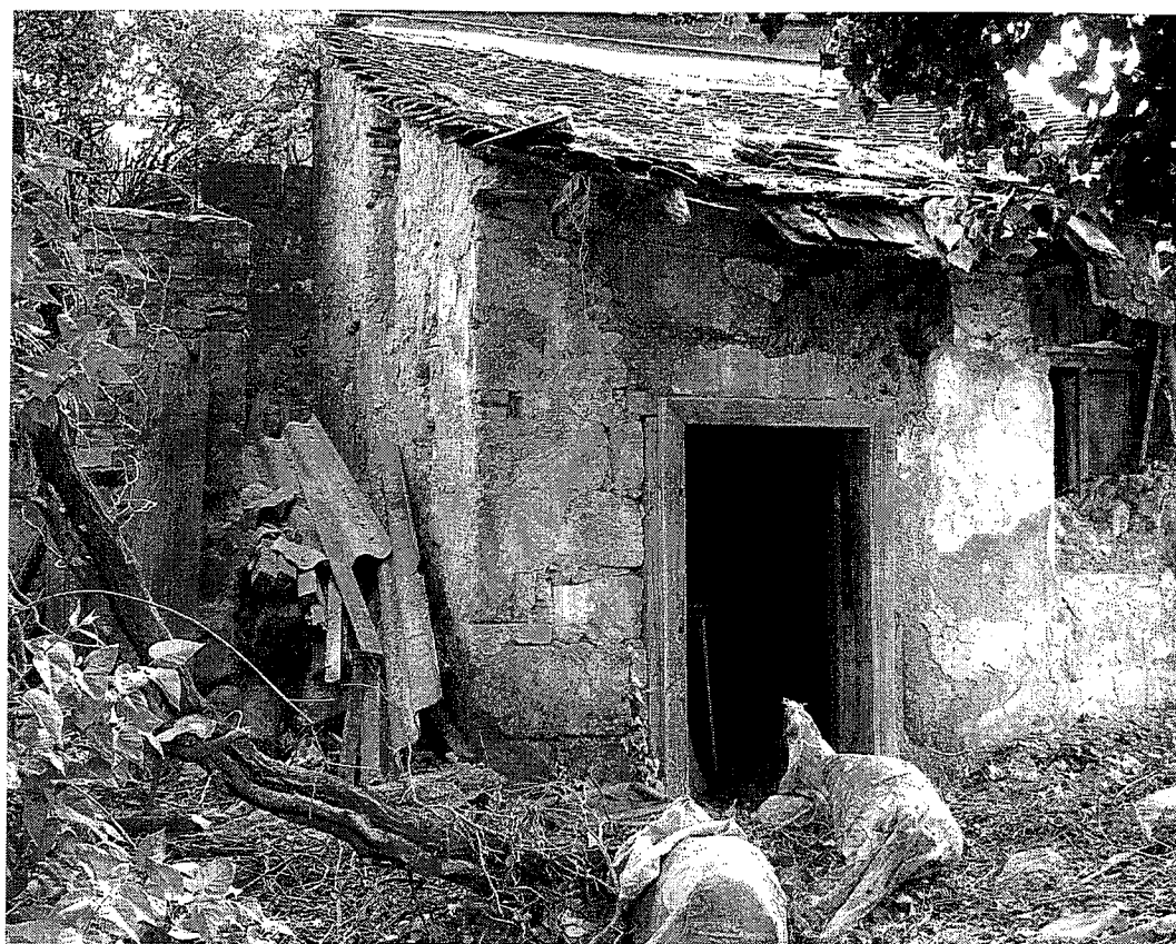
udvari homlokzat és tetőszerkezet teljes pusztulása
