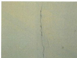
a repedezett, foltokban hámló vakolat
