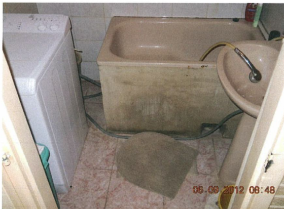
fürdőszoba, burkolás nélküli korrodált lemezkád
