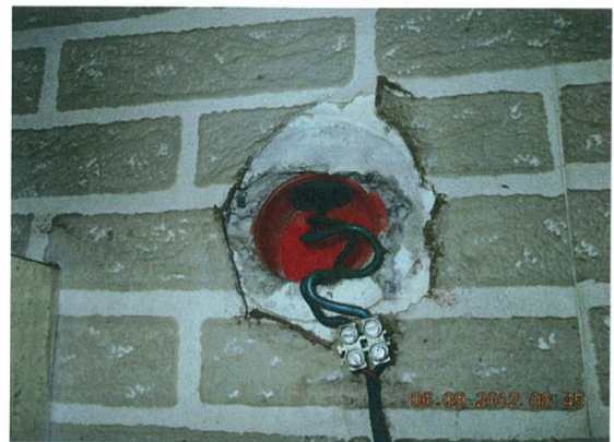
szabadon lévő elektromos vezetékek
