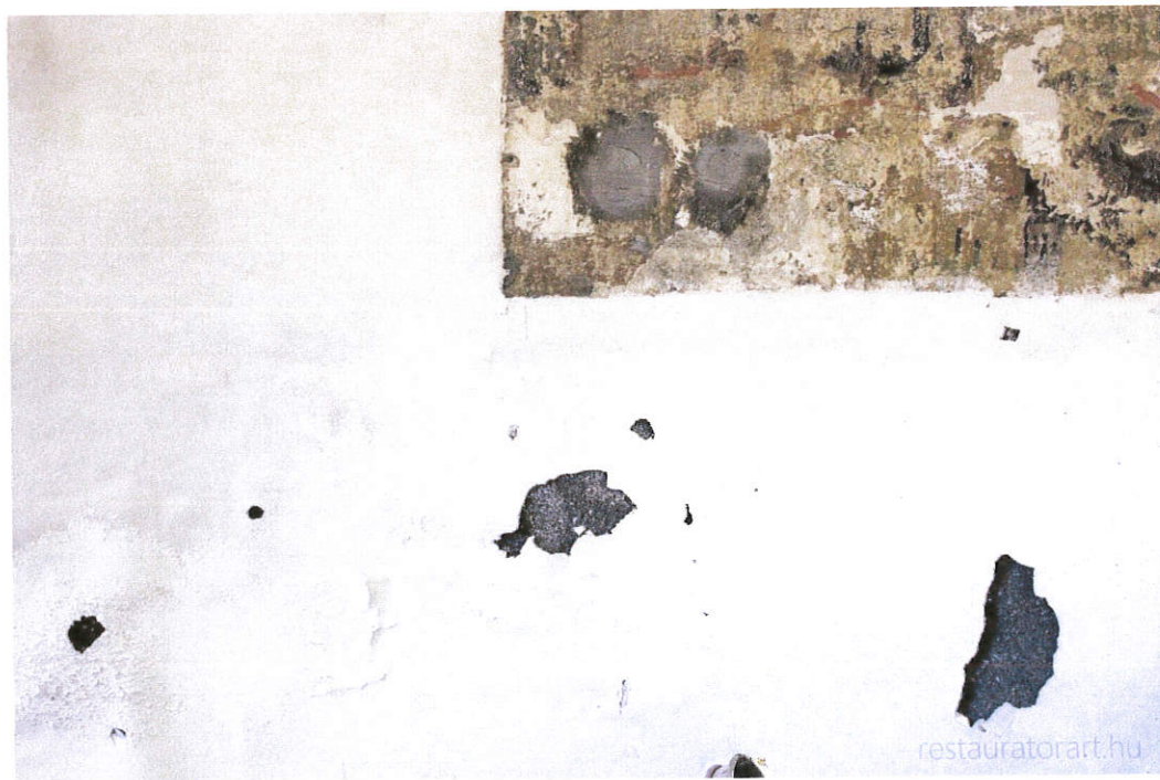
A talajnedvesség által okozott kár
