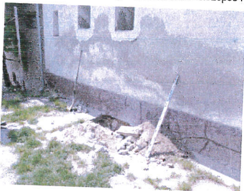
1. fénykép 1-es feltárási oldalfal nedvesedéssel
