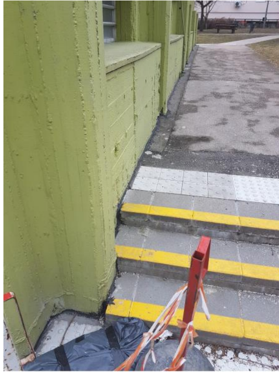
2.kép: A vizesedéssel érintett sarok
