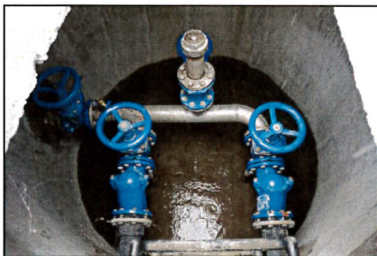
Szerelvényakna az átemelőnél
