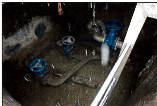
Szerelvényakna az átemelőnél
