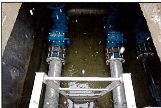
Szerelvényakna az átemelőnél
