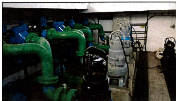
Recirkulációs gépház, cserélt KPE cső, csövek műgyantás fedése
