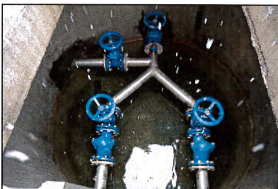
Szerelvényakna az átemelőnél
