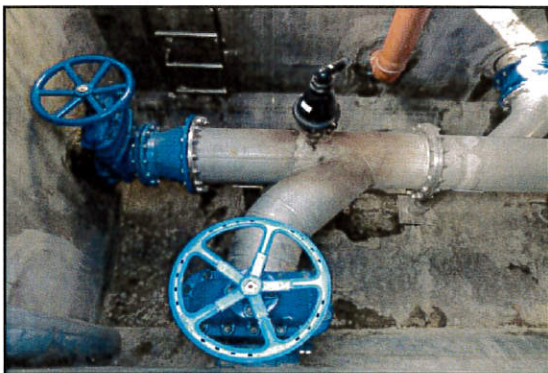
Szerelvényakna az átemelőnél
