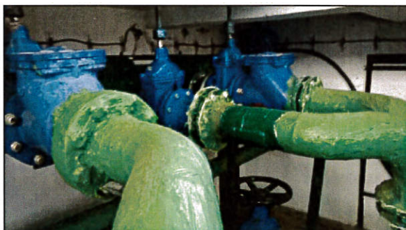
Recirkulációs gépház, műgyantás fedés javítása, csőcsere
