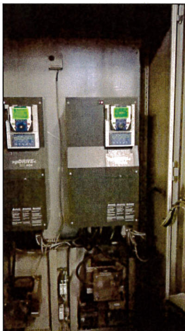
Fűtőgépházban frekvenciaváltó cserélt kijelző panel Garázs-raktár épületben selejtezendő és tartalék szivattyúk
