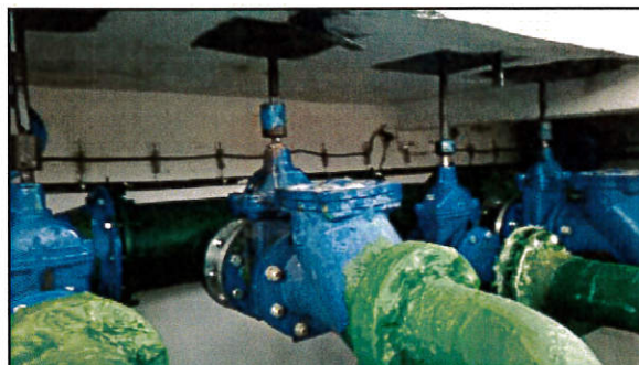
Recirkulációs gépház, műgyantás fedés javítása, csőcsere
