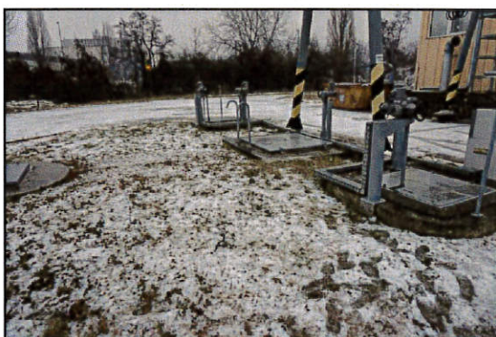
Szerelvény- és zsilipakna
