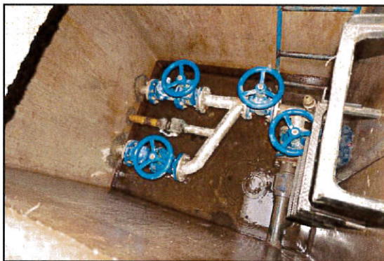
Szerelvényakna az átemelőnél
