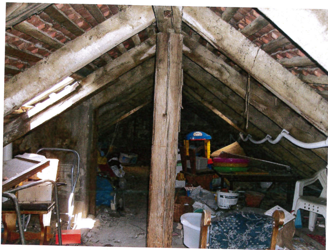
25. kép. Padlástér: Az emeletes udvari szárny tetőszerkezete I.
