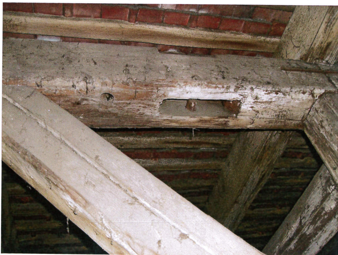
30. kép. Az előző kép részlete. Itt még jobban látható a korábbi csapolásnyom és a vizesedés okozta sérülések is.
