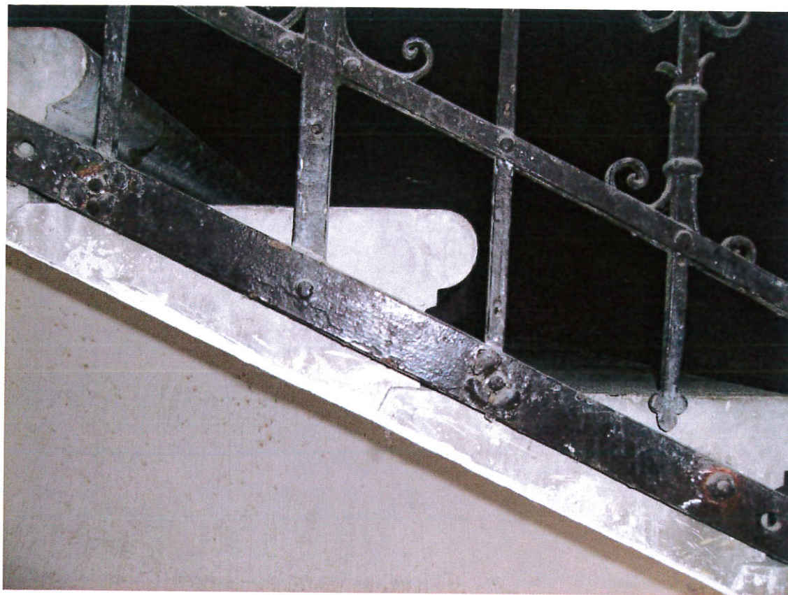
37. kép. A lépcső szerkezete.
