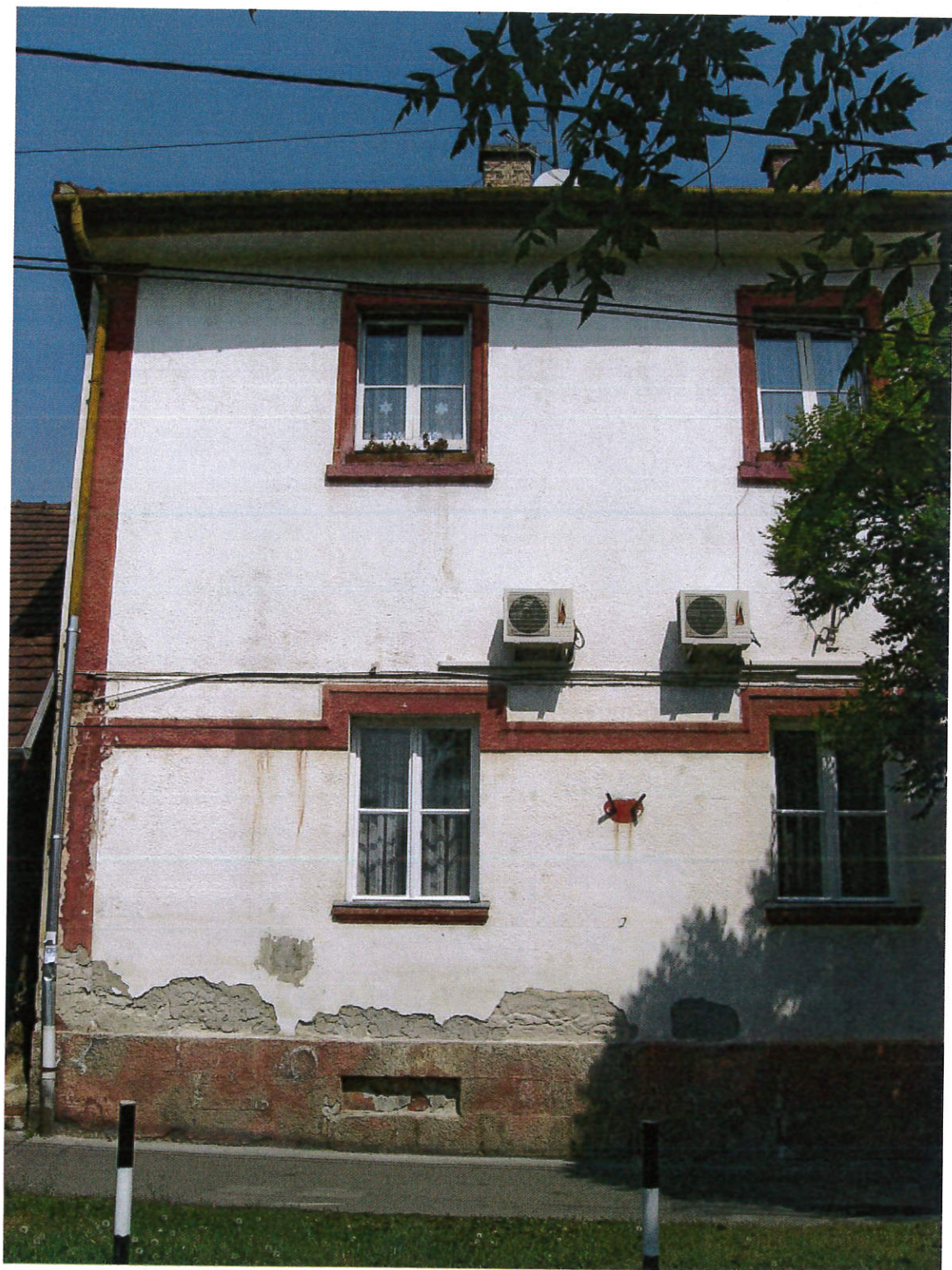
3. kép. Az utcai homlokzat jellegzetes elemei: a cementes lábazat, az eltérő kiképzésű földszinti és emeleti ablakok, a szalag osztópárkány és a lizéna. A földszint ablak alatt látható az eltömött pincerész befalazott ablaka.
