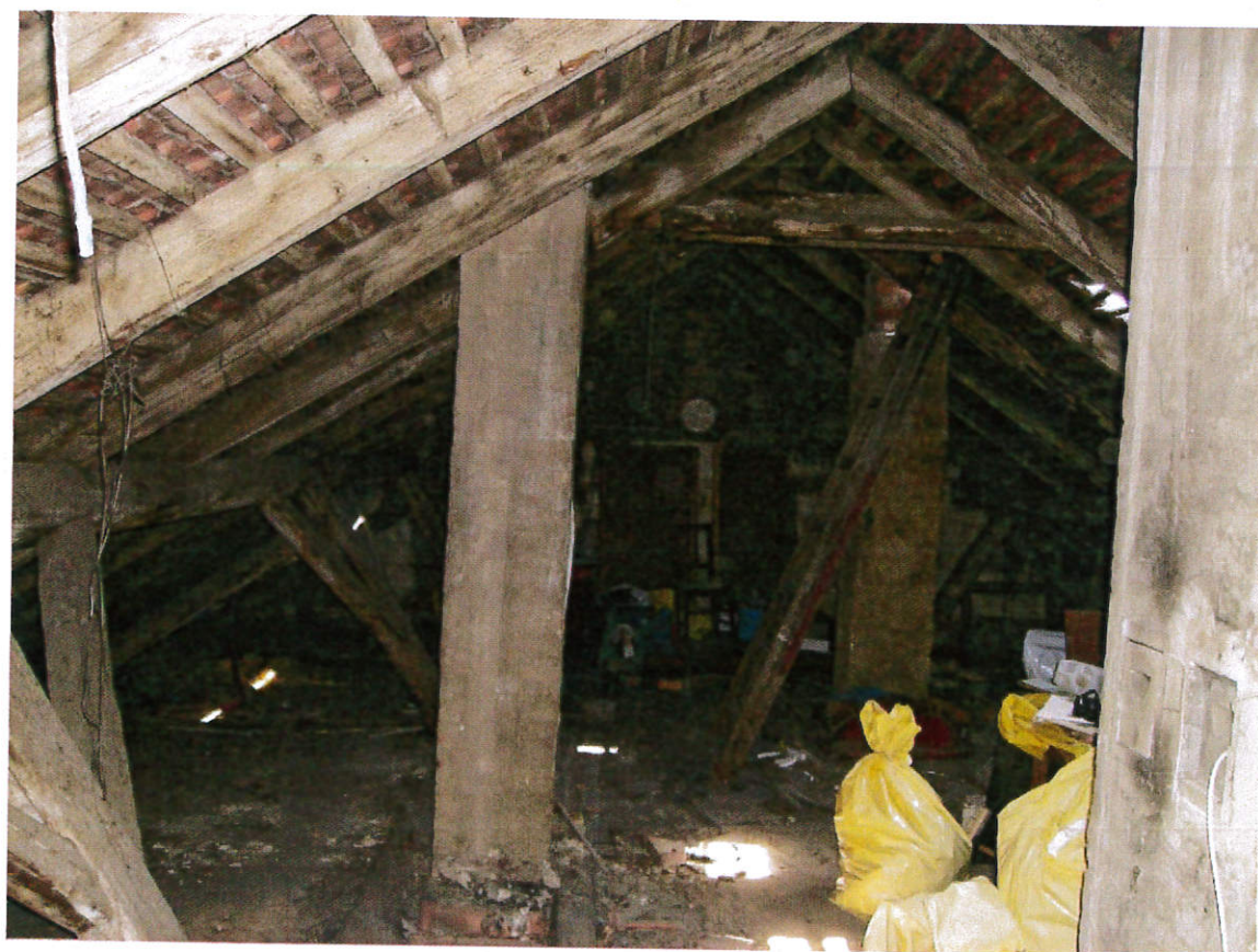
28. kép. Az utcai (déli) szárny tetőszerkezete.
