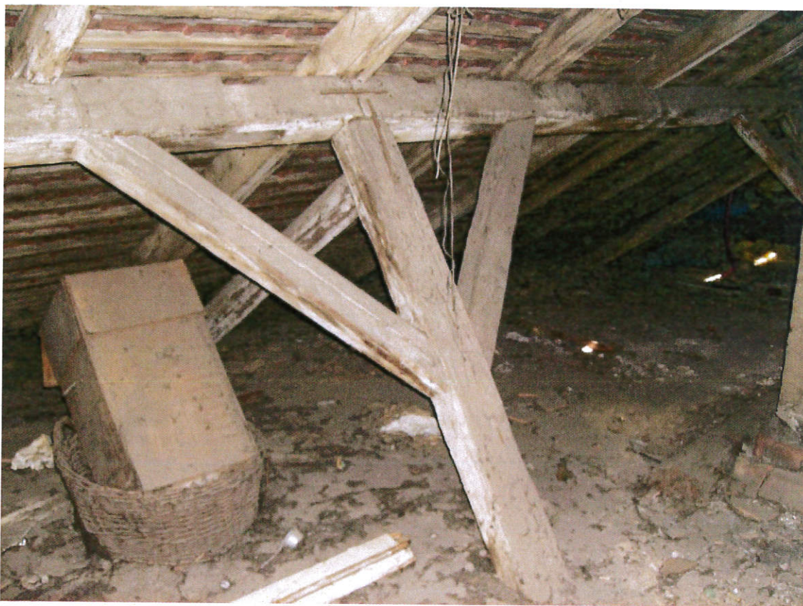
29. kép. Az utcai (déli) szárny tetőszerkezetének részlete. Látható, hogy újra felhasználták egy korábbi, talán a földszintes épülethez tartozó tetőszerkezet elemeit.
