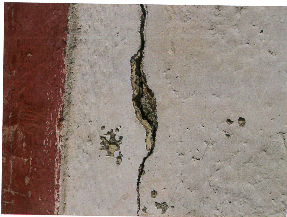
7. kép. Vakolat- és festésrétegek a kapu melletti repedésben
