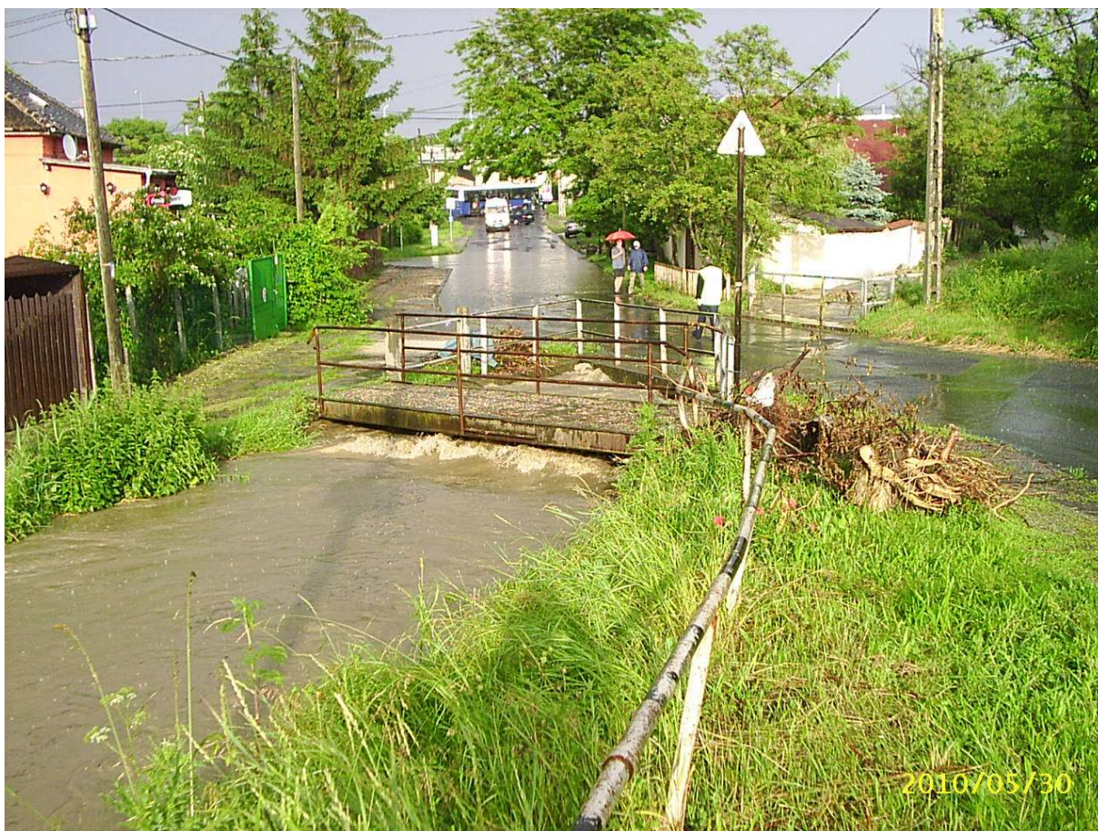
49. ábra: Az Ady Endre út alatti áteres visszaduzzasztása (forrás: FCSM ZRt.)
