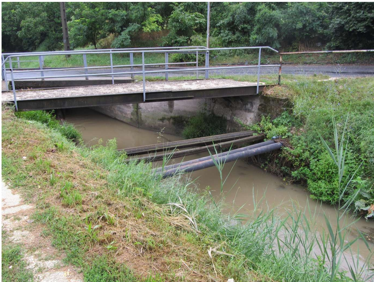
50. ábra: Az Ady Endre út alatti áteresz előtt a gyaloghíd és a keresztező közművek
