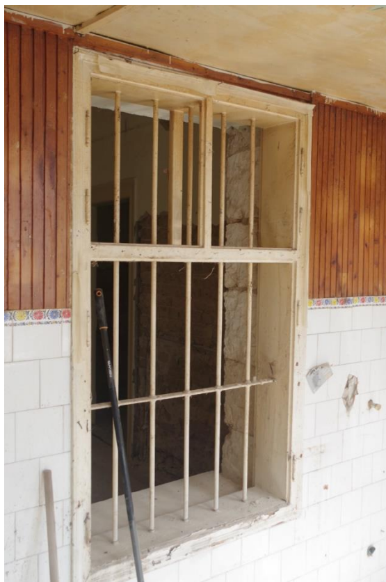
4.7. Pallótokos ablak, hiányzó szárnyak a 4-5. helyiségek között
