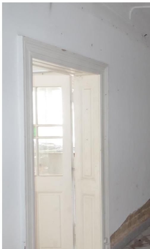
4.34. Táblabetétes üvegezett belső ajtó nézetei (1-2. helyiség között)
