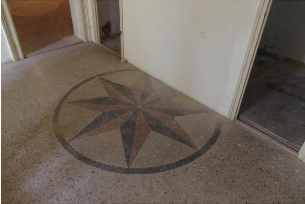
4.23. 05. helyiség terazzo burkolata és az utólagosan leválasztott helyiségek válaszfalai
