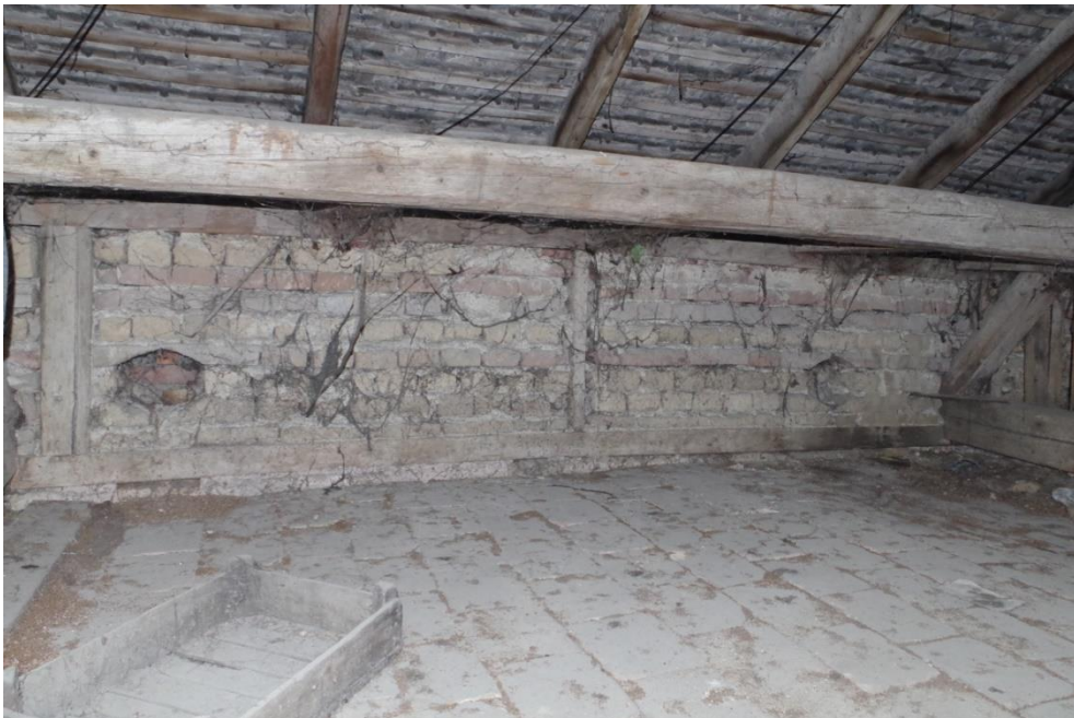
4.31. Szellőzőnyílások utólagosan befalazva az utca felőli térdfalban
