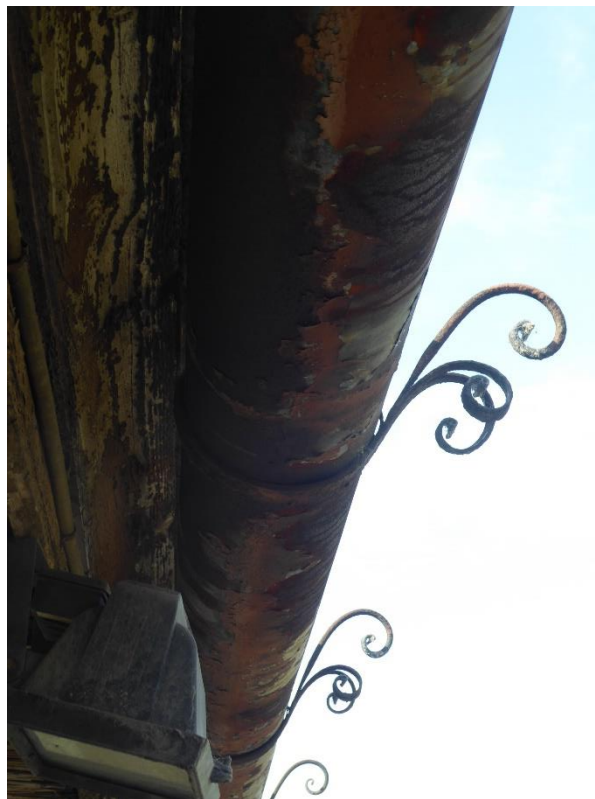
4.4. Északi homlokzat- ereszcsatorna és a díszes rögzítőkarmok
