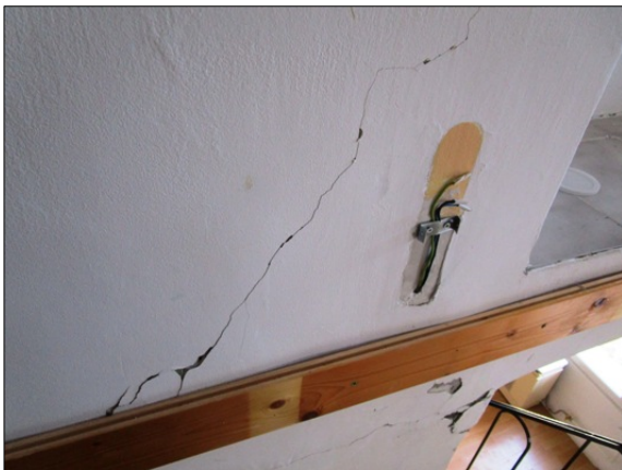
Fal repedés
