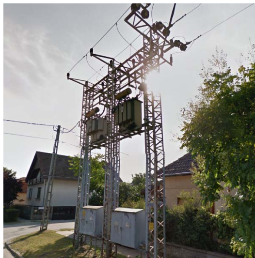
0258-as sz. 20/0,4 kV-os transzformátor
