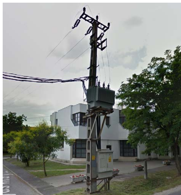
0353-as és 0943-as sz. 20/0,4 kV-os transzformátorok
