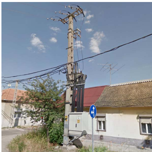
1003-as sz. 20/0,4 kV-os transzformátor
