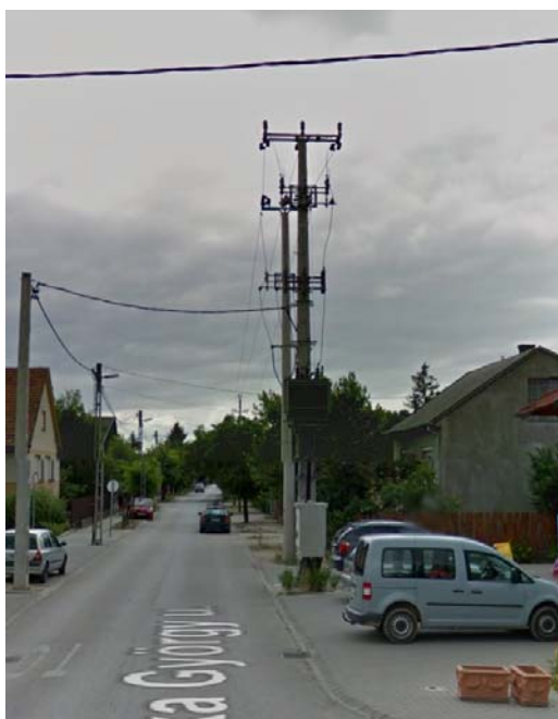
0152-es sz. 20/0,4 kV-os transzformátor
