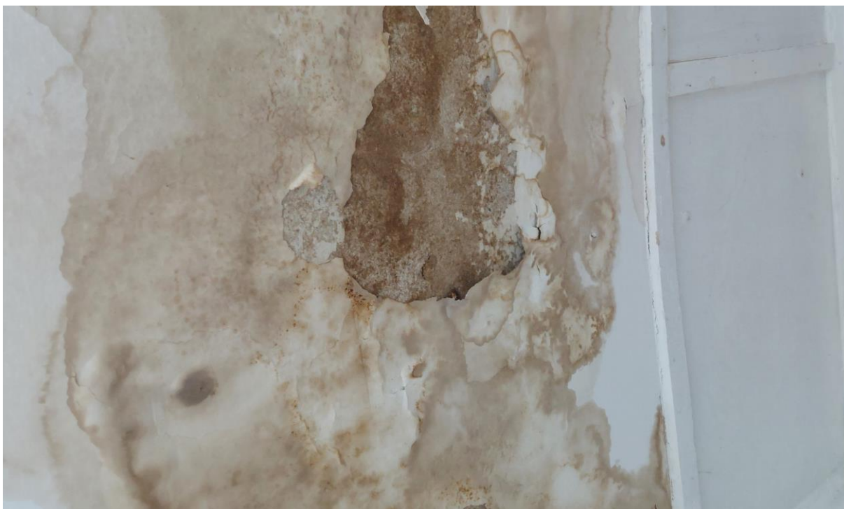
10. kép: belső helység mennyezet beázás nyomai
